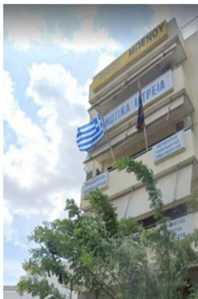
Ιατρείο – Πετράλωνα Πειραιώς 108, 1ος όροφος
