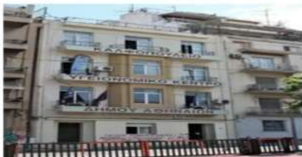
1 ο Πολυδύναμο Κέντρο – Δημοτικό Ιατρείο – Καλφοπούλειο Υγειονομικό Κέντρο Σόλωνος 78
